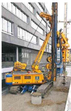
**PFAHLHERSTELLUNG** mit einer Bauer BG 40 unter beengten Platzverhältnissen.
